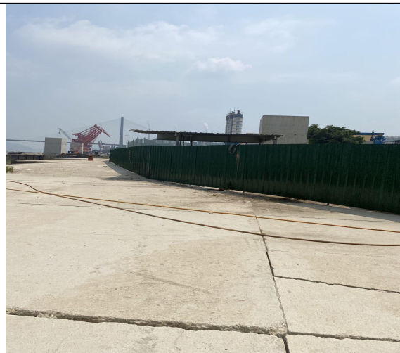
施工期靠江一侧围挡
