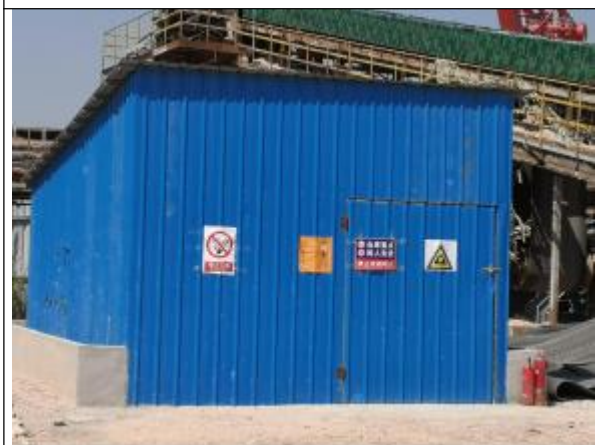
危废临时贮存所
