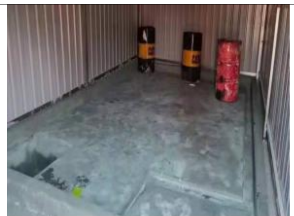
贮存所围堰及防渗
