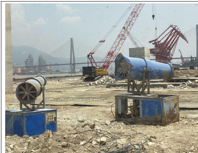
施工期雾炮进行喷雾抑尘
